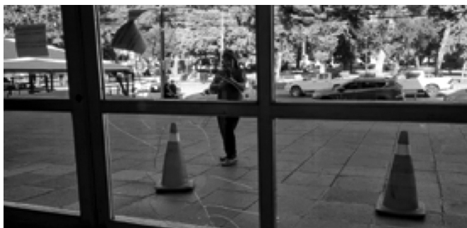
Daños en el ingreso a la Catedral de Chillán. ©Diócesis de Chillán
